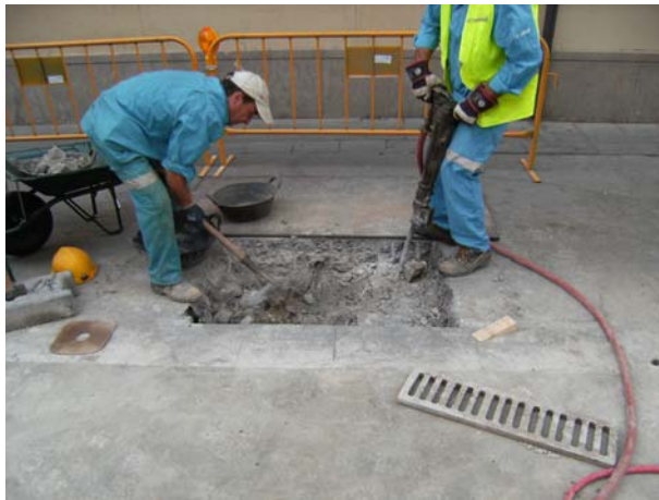
FOTO 3. Vista general de les tasques excavació
