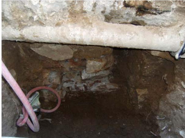
FOTO 9. Vista de detall de les tasques de desmuntatge del mur UE06
