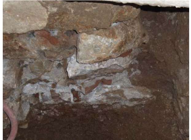
FOTO 10. Vista de detall del parament intern del mur UE06 durant les tasques de desmuntatge
