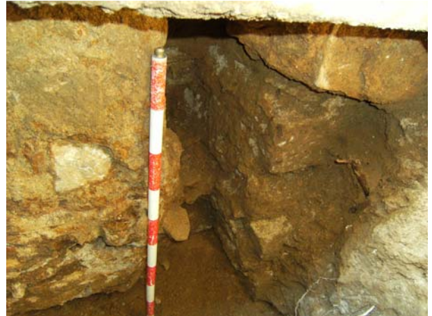
FOTO 6. Vista de detall del mur de pedra (UE06). Podem observar la obertura i el parament lleugerament diferent del costat dret
