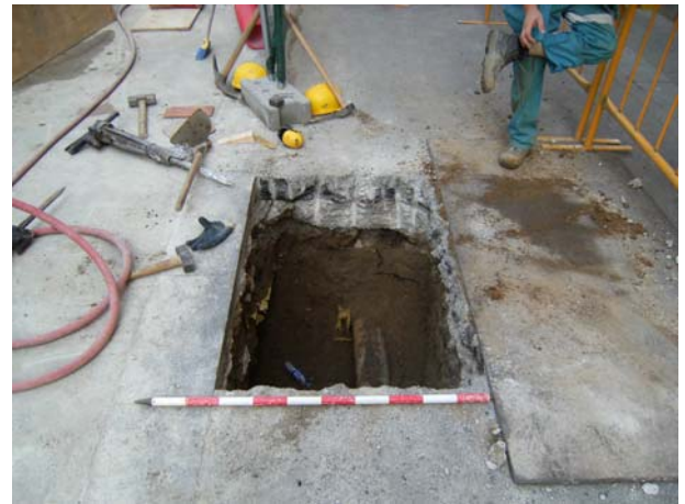
FOTO 4. Vista de detall de la UE05 on s'observa la canalització de gas contemporània
